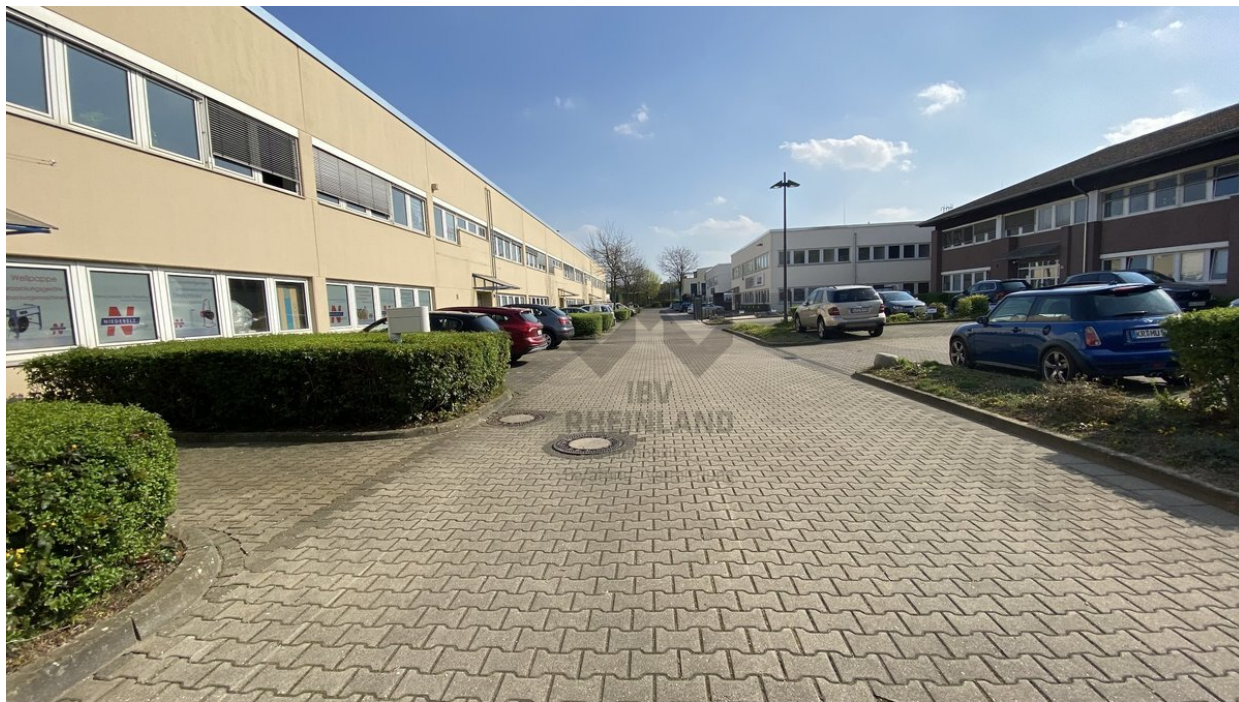
Zufahrt und Parkplatz
